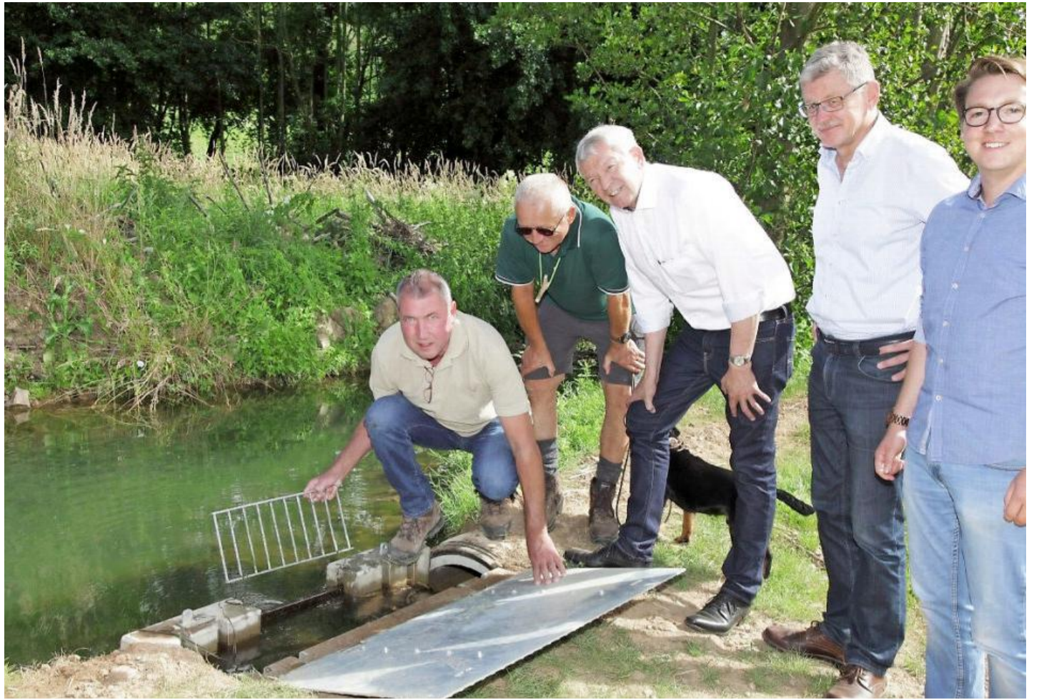
Der Bibermönch funktioniert prima. Die Konstruktion macht es möglich, die Interessen von Biber und Mensch zu vereinbaren.
